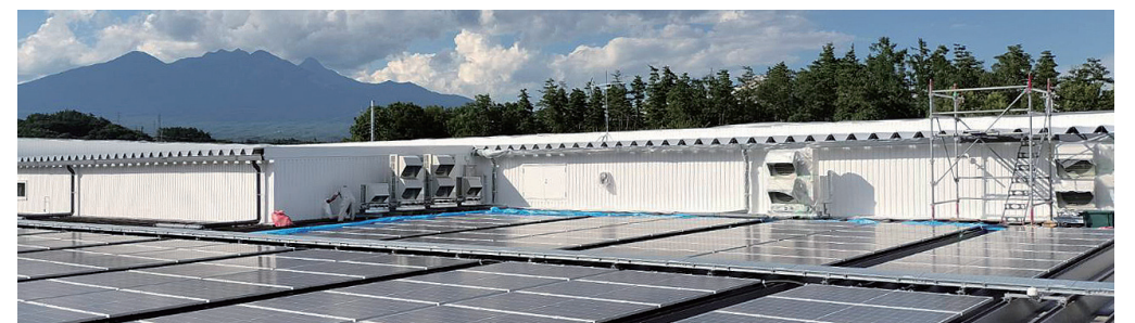
塗装後の事務所折板屋根（塗装面積 760㎡）と外壁（塗装面積 300㎡）の様子
