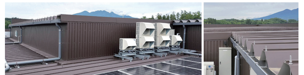
塗装前の事務所外壁（左）と折板屋根（右）
